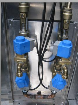
Die Wasserzufuhr zum adiabatischen Vorkühler sichert eine elektromechanische Ventilanordnung. Das Berieselungswasser wird zugeführt, wenn die elektromechanischen Ventile aktiviert werden. Die Ventilanordnung ist ergänzt mit voreinstellbaren Reglern, um den korrekten Massenstrom sicherzustellen, diese ist in die Steuereinheit integriert.
